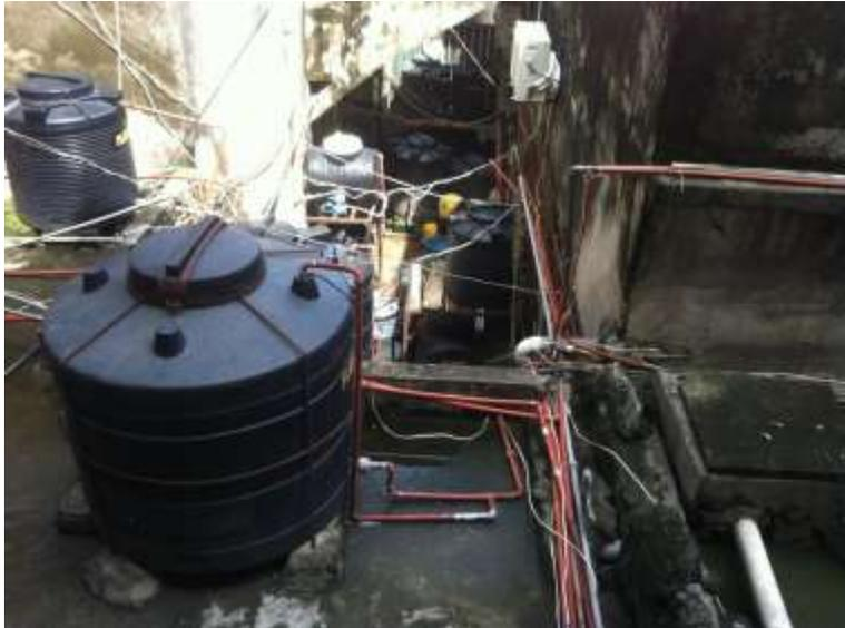
Este sistema labiríntico de tubos, bombas, válvulas, reservatórios em combinação com um sistema de energia eléctrica representa um perigo para os munícipes. No passado recente funcionava na maioria dos prédios uma cisterna (em baixo do prédio) e um tanque (acima do prédio) colectiva, com que a água potável foi fornecida nas casas. Presentemente o sistema não funciona.
