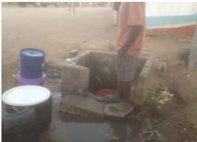
Figura 35 Fotografia de um fontenário com falta de pressão
